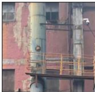
采样平台 (抛丸机排气筒 DA001 出口)
