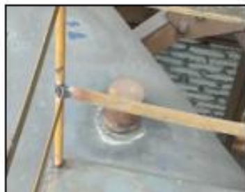
监测孔 (进口) (抛丸机排气筒 DA001 进口)
