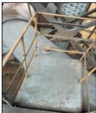
采样平台 (抛丸机排气筒 DA001 进口)
