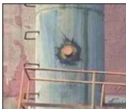
监测孔 (抛丸机排气筒 DA001 出口)
