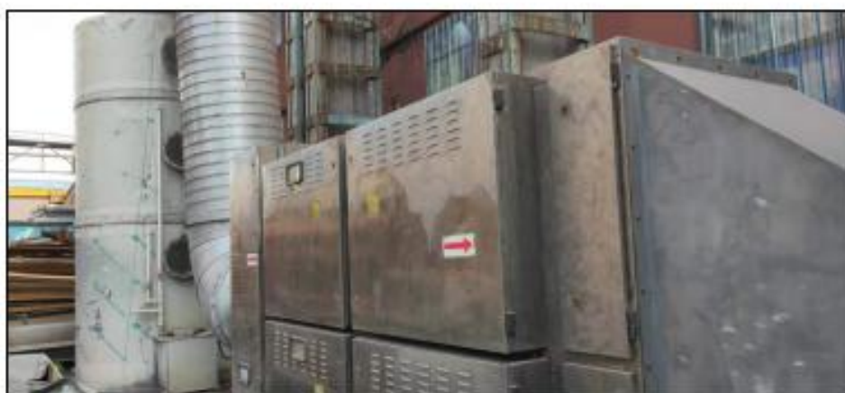
水喷淋+光氧催化一体机净化装置
