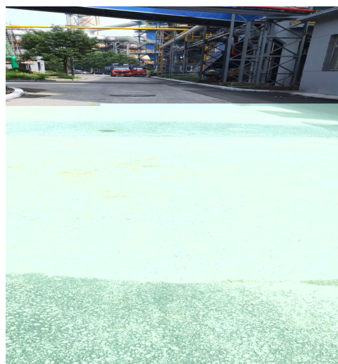
厂区地面硬化
