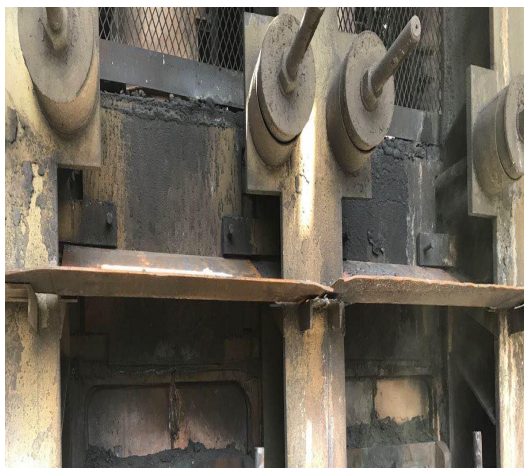
挡烟板（碳化室机侧炉柱上方与托架下方）
