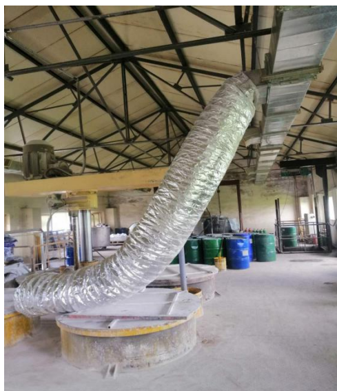
2 车间罐体顶部密封
